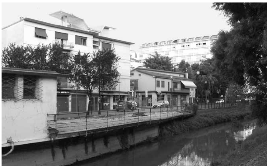
In alto: ramo nord, il ponte del Castelvecchio giace in avanzato stato di abbandono. In basso: cementificazione delle rive presso villa Querini (ramo sud).
