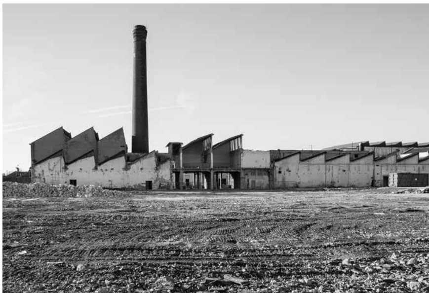
La demolizione del lanificio Tiberghien (Archivio Ivres, fotografia di Valentina Festo).
