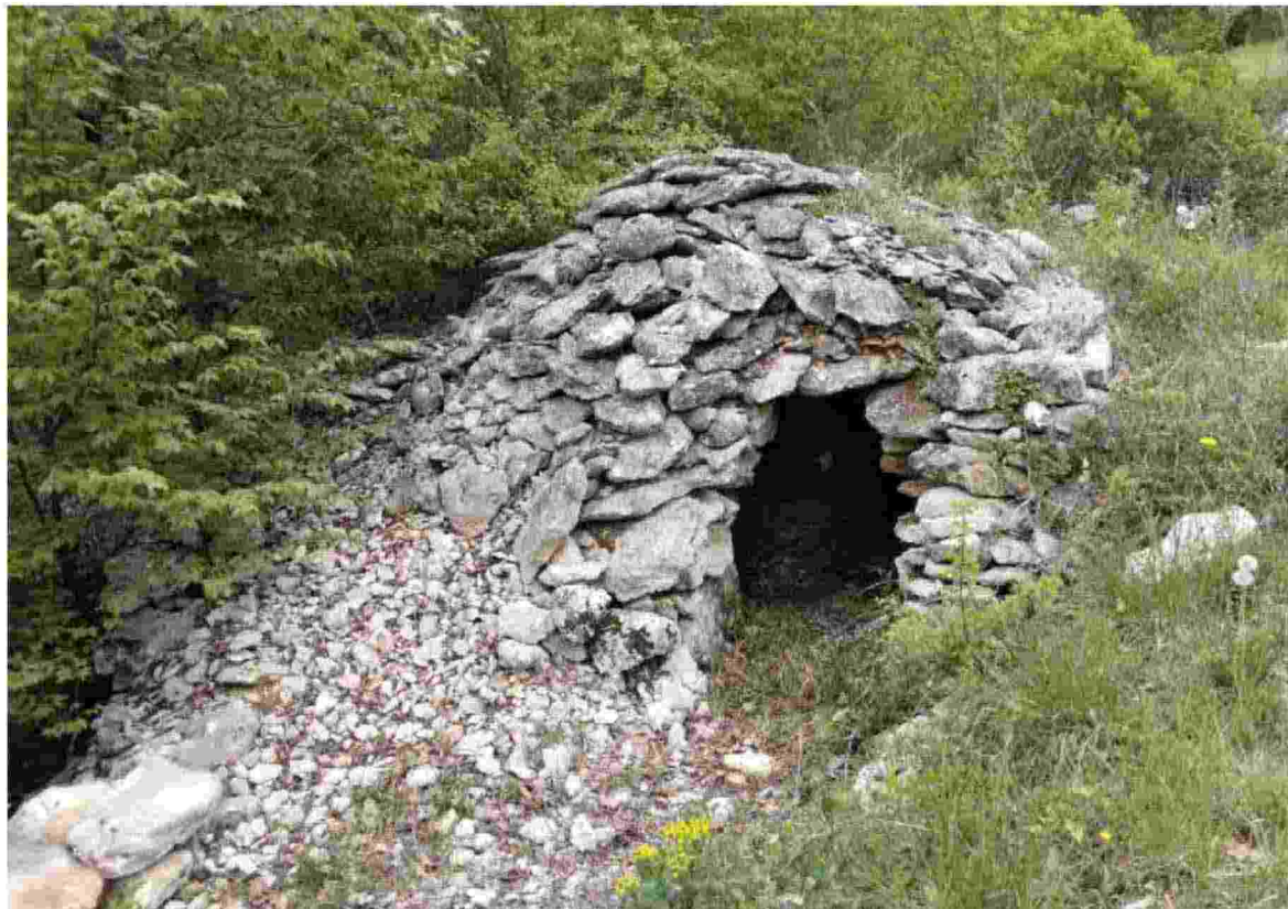
Sul Monte Faeo Il "Casotto Ferron" o "dell'Arboreto": sul lato sinistro sono state aggiunte, nel tempo, altre pietre di varie dimensioni. FOTO ALBERTO GIRARDI
